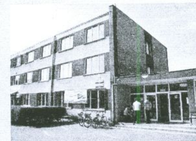
Budynek puckiego PCKU
